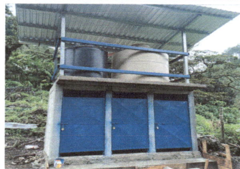
Foto 2: Instalaciones de las puertas de banos
