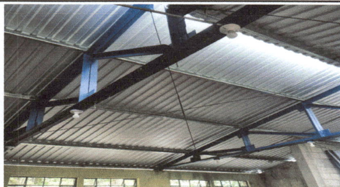
Foto 3: Instalacion de estructura de costaneras
