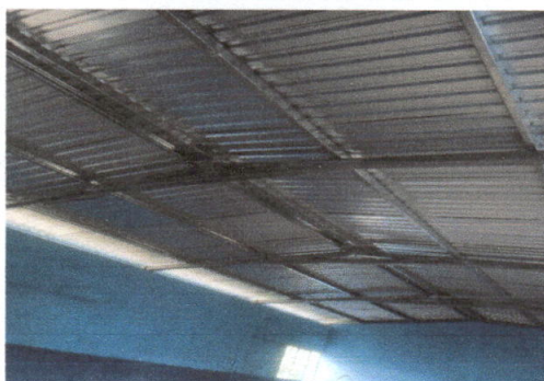
Foto 4: Instalación de cubierta de lámina/troquelada.
